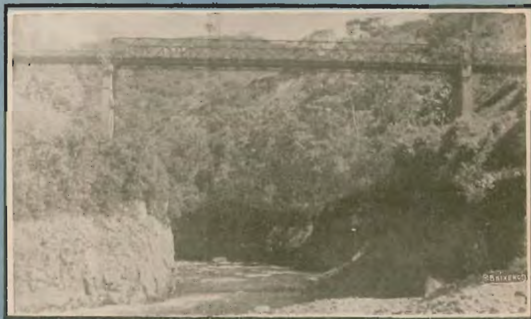
Puente sobre el río Reventazón, en la región de Cachi, recientemente inaugurado.
